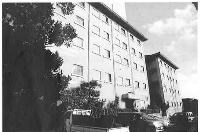
「ホテル山水」の新館と別館
